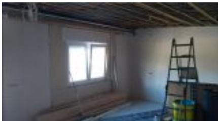
03.09.2020 – Tobias demonitierte die restlichen Rigipsteile der alten Decke, damit die neue Akustikdecke fachgerecht mit einer Dampfsperre eingebaut werden kann.
