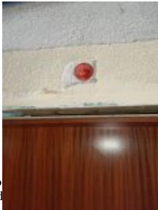
z.B. wurde der Zentralschalter herausgemeißelt und elektrisch überbrückt, so dass die Heizung weiterhin in Betrieb war und gefahrlos bei geputzt werden konnte.
