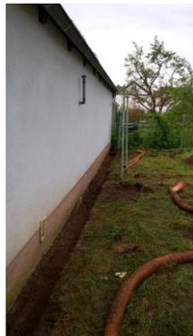
Der Untergrund besteht aus Restbeton und zum Teil nur aus aufgefüllten Boden. Zu dem war eine Durchnässung festzustellen. Die leichte Hanglage und eine verstopfte und zu hoch liegende Drainage hatten für das eindringende Wasser durch Fundament und unterster Steinreihe der Wand gesorgt. 09.05.2020
